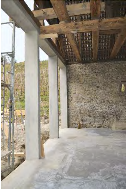
Der Einbau des Stahlbetonrahmens der Westfassade.
