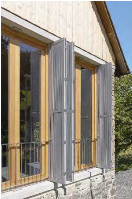
Der statisch notwendige Stahlbetonrahmen ist gleichzeitig Rahmen für Fenster und Läden.
