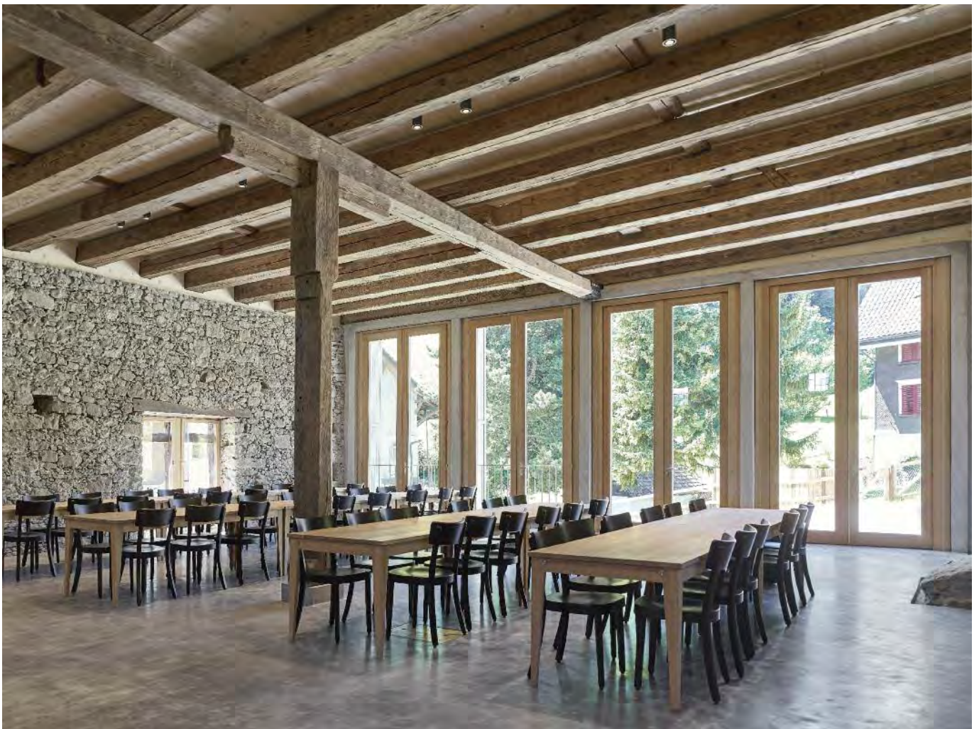
Das unverputzte Mauerwerk und die Deckenbalkenlage mit Unterzug und Mittelpfosten prägen den alten Torkelraum.
