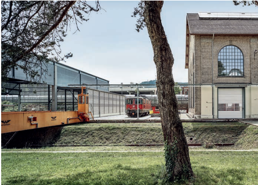
Eine Verschiebeeinrichtung verbindet die SBB-Hallen in Zürich-Altstetten mit der neuen Halle links.
